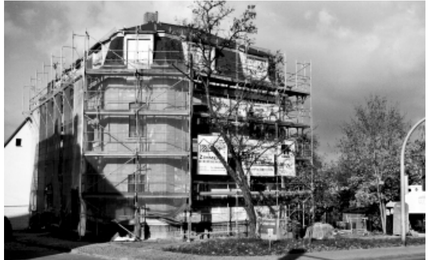
Geraer Straße 2 – Ende des Jahres werden die Arbeiten abgeschlossen sein.
