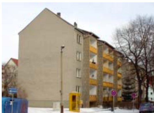
Der Wohnblock Goethestraße 21/23 vor Beginn der Umbauarbeiten.
