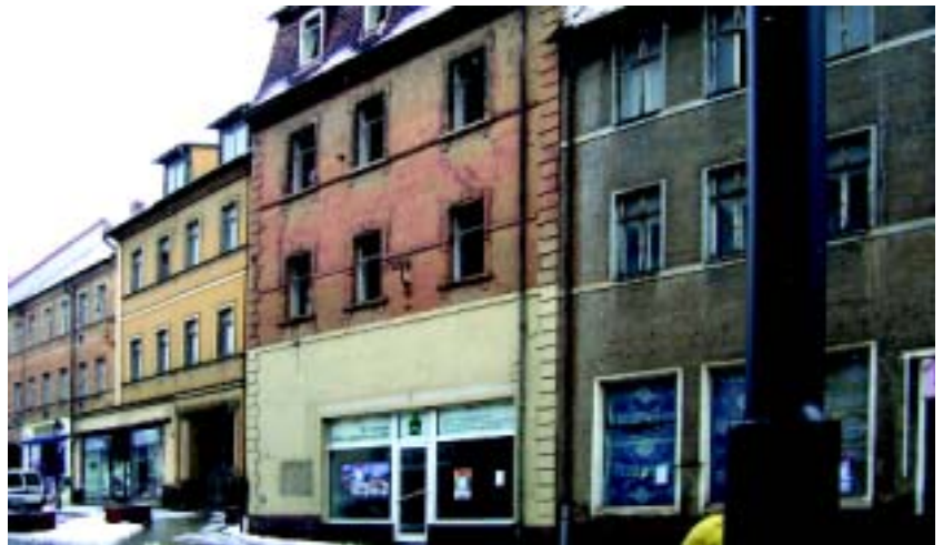
Dieses Gebäude ist mittlerweile schon aus dem Stadtbild verschwunden.
