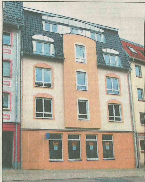
Die neue Hausfront an Ronneburgs Hauptstraße.
