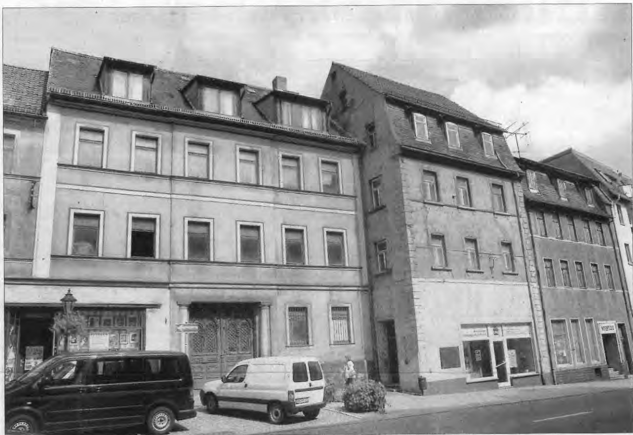
Vier Häuser am Ronneburger Markt sollen ein neues Gesicht bekommen: Die Ronneburger Wohnungsgesellschaft und die Landesentwicklungsgesellschaft Thüringen planen Sanierungen und Neubauten anstelle der Ruinen. Der Abriss soll bereits Mitte Oktober beginnen. (Foto: OTZ/Katja Schmidtke)
