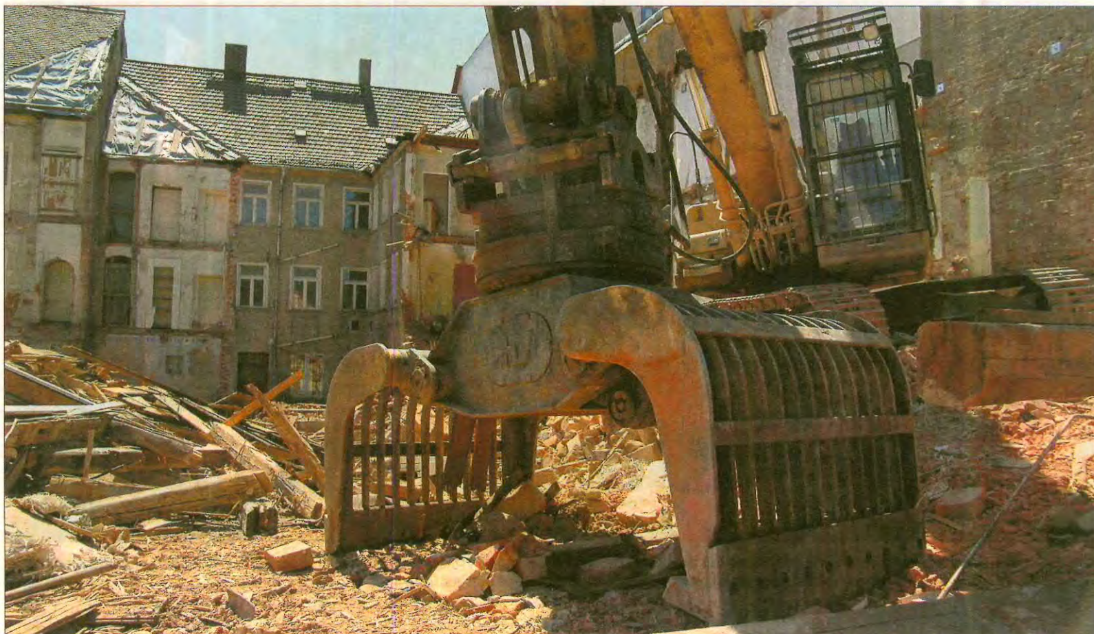
Der Abriss am Ronneburger Markt geht in die letzte Phase: In dieser Woche soll das Nebengebäude des Hauses Markt 13 weggebaggert werden. Weil hier Haus an Haus steht und das Nachbargebäude in privatem Besitz ist, erfordern die Arbeiten Fingerspitzengefühl. Foto: Katja Schmidtke
