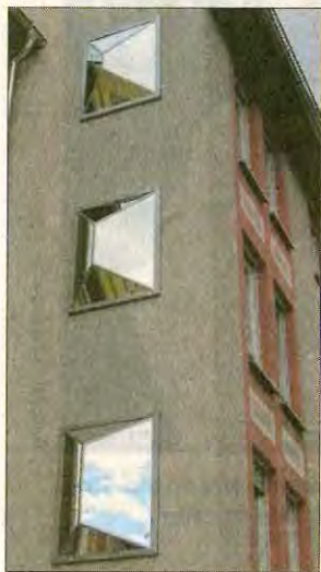
Gebäude, blauer Himmel und Wolken spiegeln sich in an der Hausfassade am Markt. Foto: RWG
